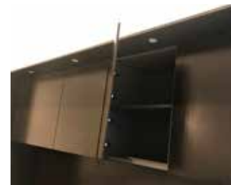
Küchenfronten aus Stein Bei Laden und Drehtüren aufgeklebt, oder so wie hier auf 12 mm Nero Assoluto Scharnierbohrungen eingefräst und direkt montiert.
